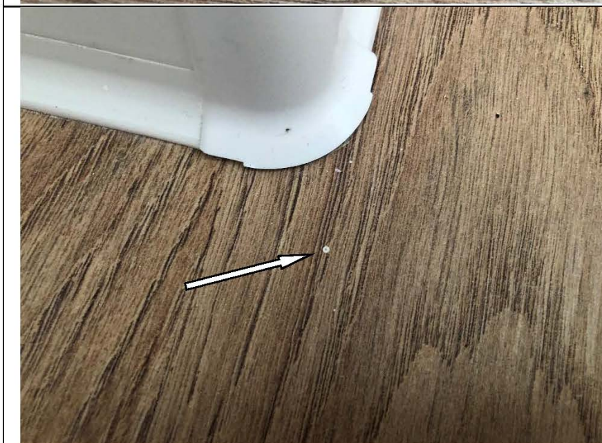
Фото №57. Загрязнения на поверхности ламината в спальне в квартире.
