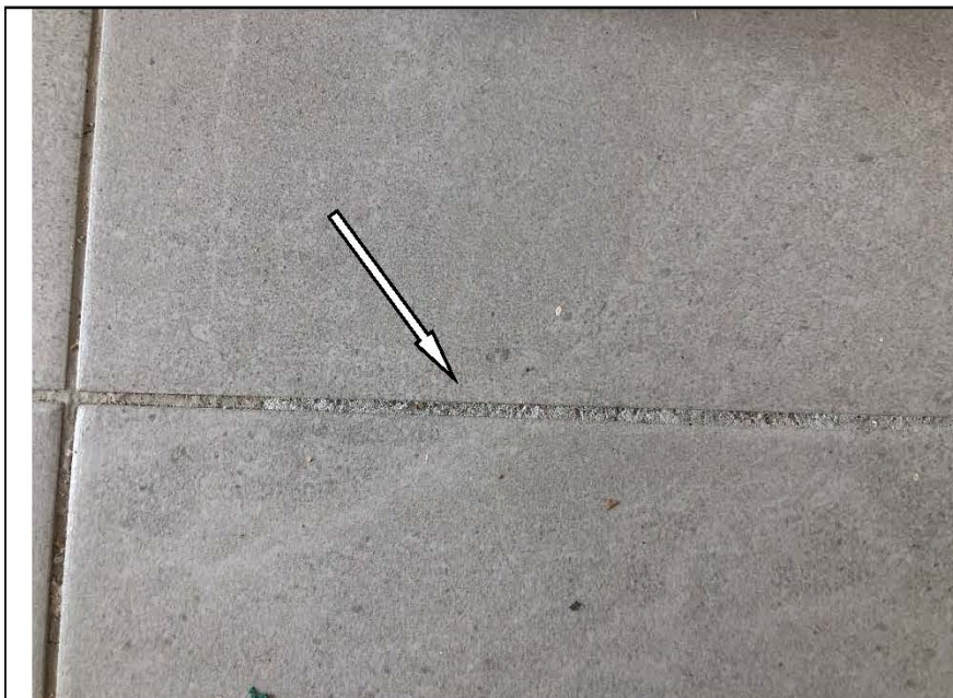
Фото №25. Неровный шов напольной керамической плитки в кухне в квартире.
