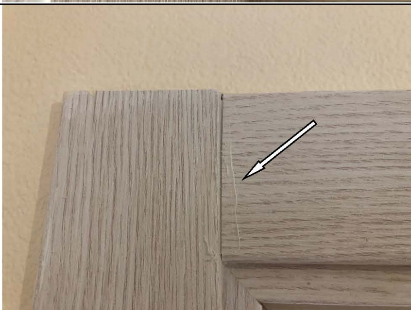
Фото №12. Загрязнения на наличнике деревянного дверного блока в ванной комнате в квартире.
