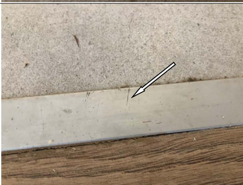
Фото №51. Дефект на напольном металлическом порожке в спальне в квартире.
