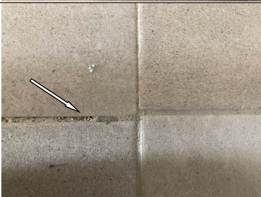
Фото №24. Неровный шов напольной керамической плитки в коридоре в квартире.
