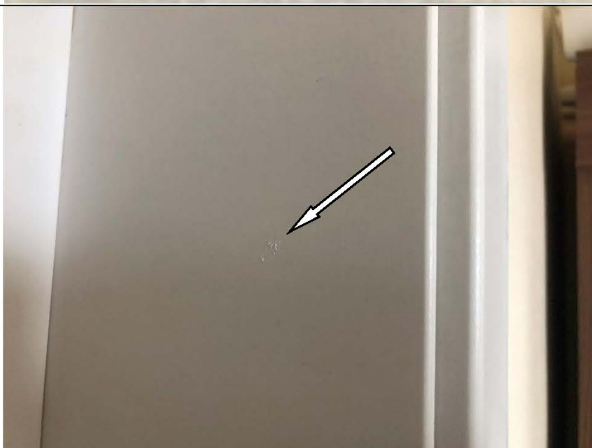
Фото №9. Скол на наличнике комбинированного дверного блока в коридоре в квартире.
