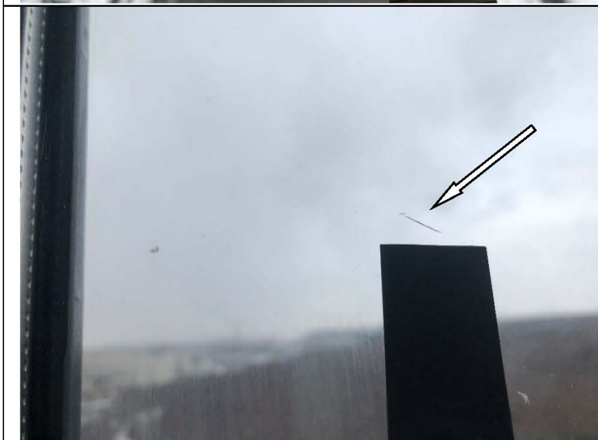
Фото №42. Царапина на стеклопакете оконного блока ПВХ в спальне в квартире.
