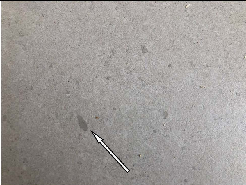
Фото №22. Загрязнения на напольной керамической плитке в кухне в квартире.
