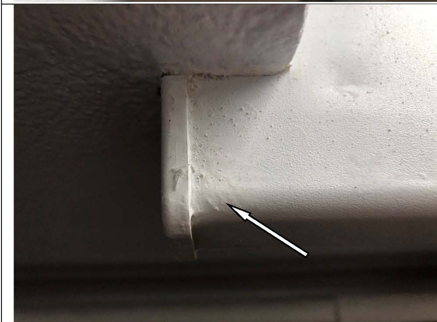
Фото №38. Загрязнения на подоконной доске в спальне в квартире.
