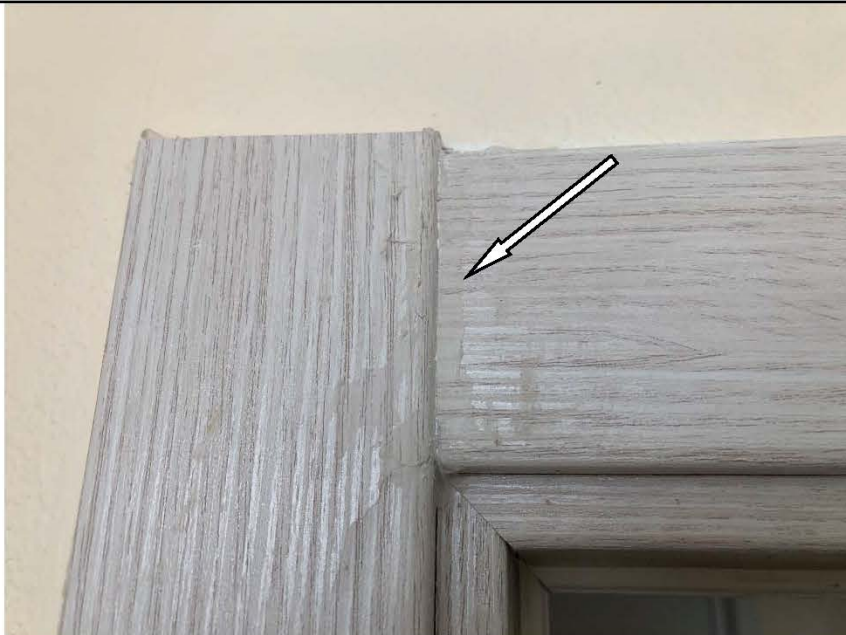
Фото №10. Загрязнения на наличнике деревянного дверного блока в кухне в квартире.
