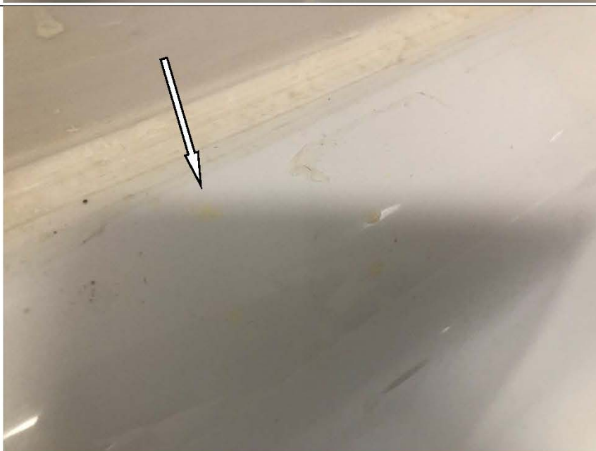
Фото №62. Загрязнения на ванной в ванной комнате в квартире.
