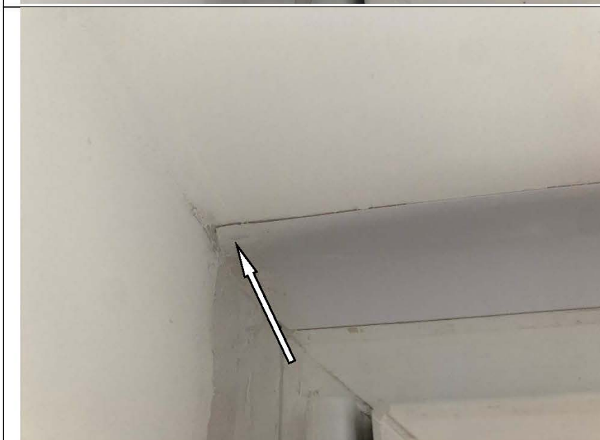
Фото №44. Инфильтрация оконного блока ПВХ в спальне в квартире.
