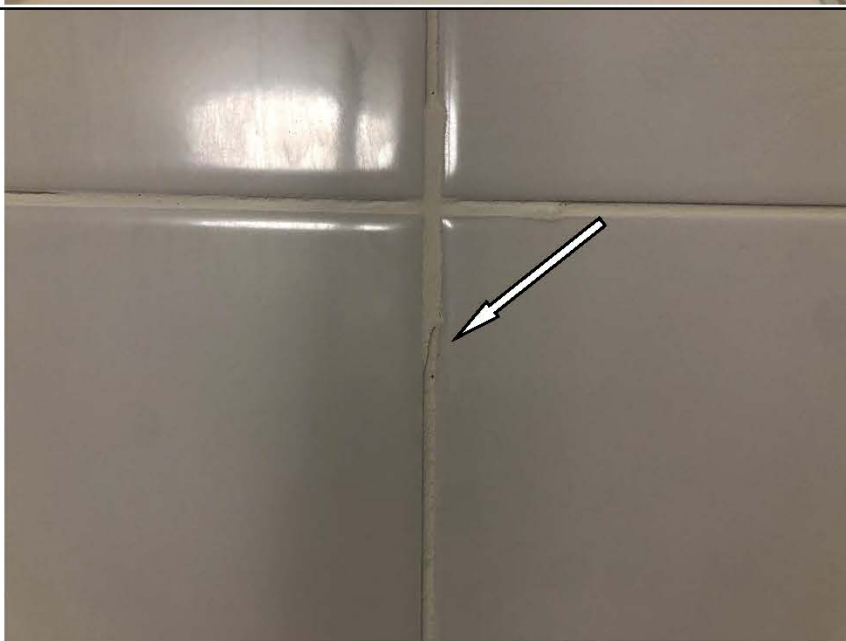
Фото №60. Неровный шов настенной керамической плитки в ванной комнате в квартире.
