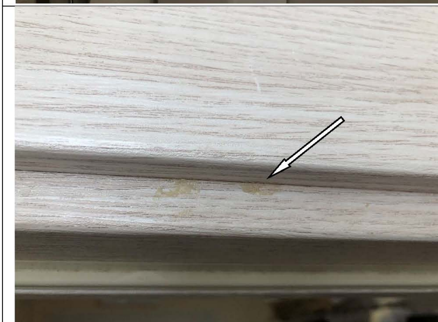
Фото №14. Загрязнения на коробке деревянного дверного блока в кухне в квартире.
