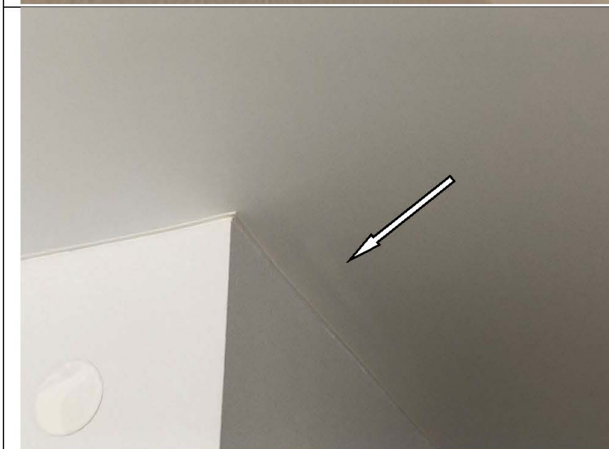
Фото №32. Загрязнения на полотне натяжного потолка в спальне в квартире.
