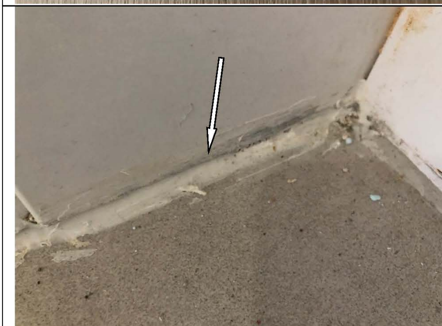
Фото №21. Загрязнения на напольной керамической плитке в коридоре в квартире.
