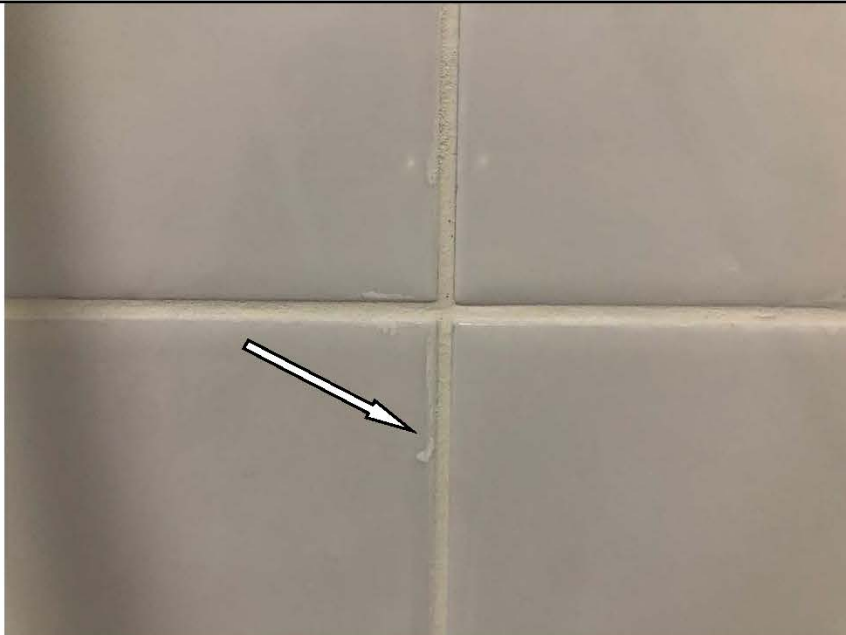
Фото №61. Загрязнения на настенной керамической плитке в ванной комнате в квартире.
