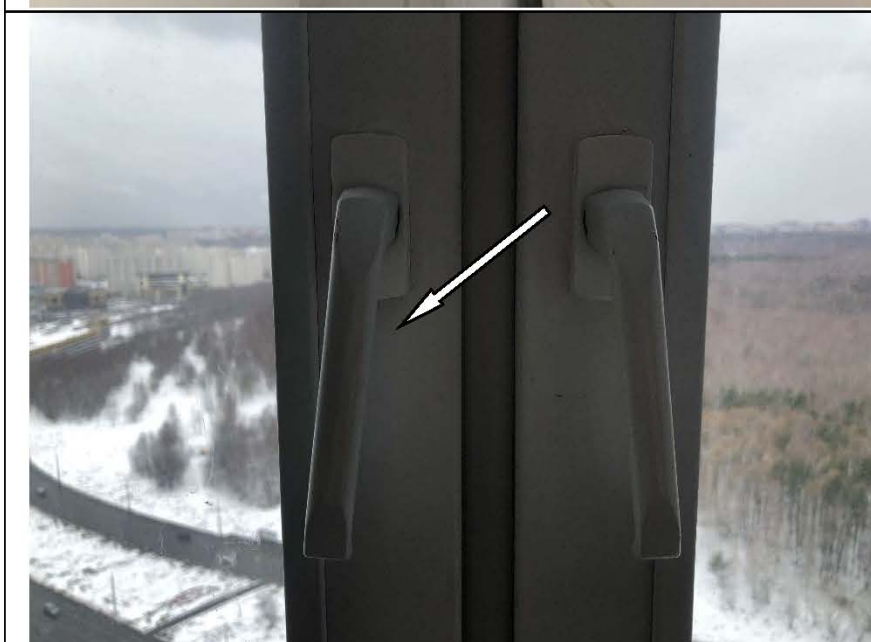
Фото №45. Не отрегулирована фурнитура оконного блока ПВХ в кухне в квартире.
