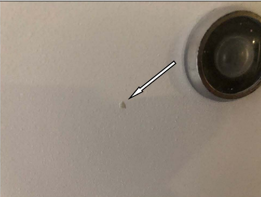
Фото №17. Загрязнения на полотне комбинированного дверного блока в коридоре в квартире.
