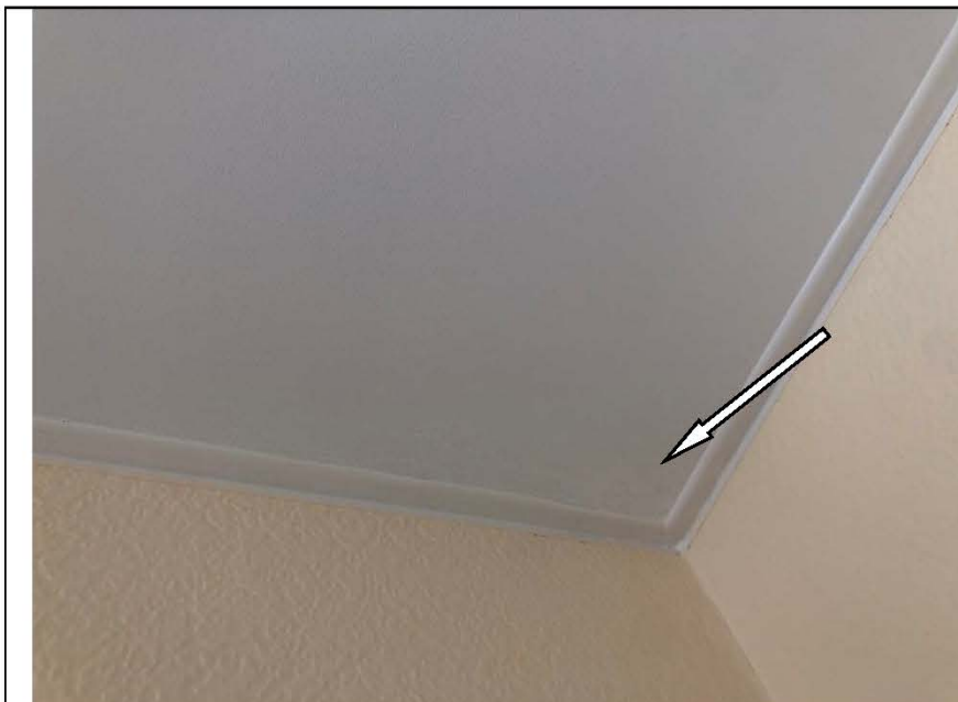
Фото №31. Загрязнения на полотне натяжного потолка в кухне в квартире.
