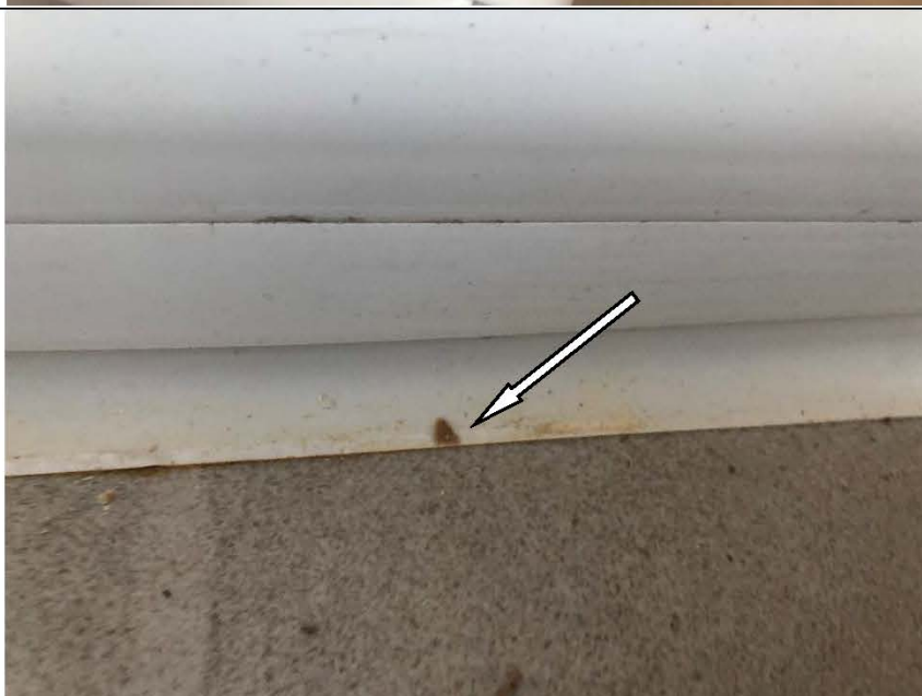
Фото №50. Дефект на напольном металлическом порожке в кухне в квартире.
