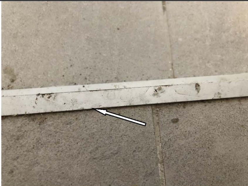
Фото №52. Дефект на напольном металлическом порожке в ванной комнате в квартире.
