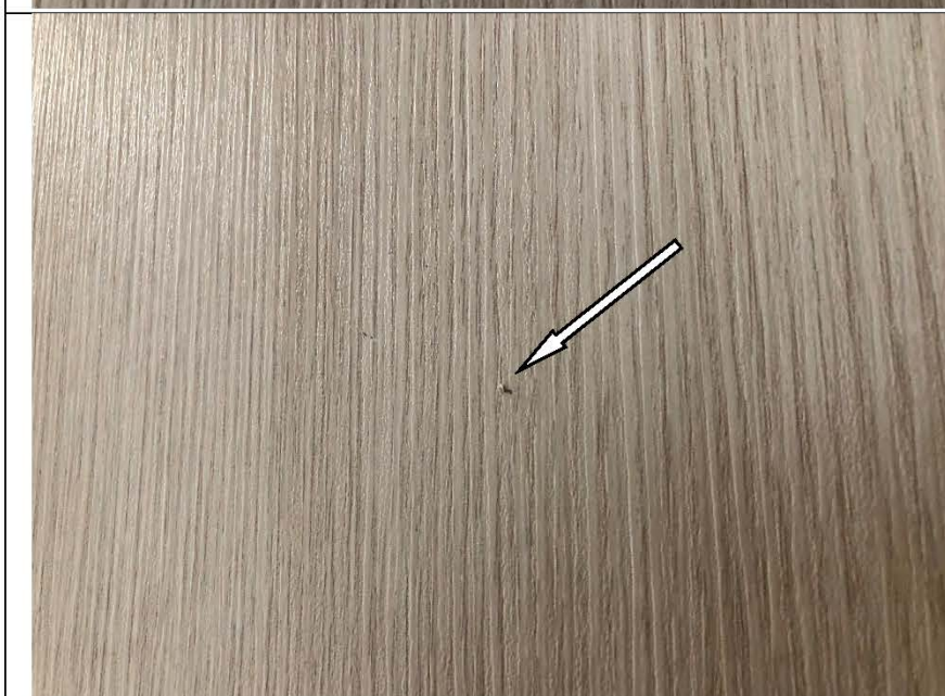
Фото №20. Скол на полотне деревянного дверного блока в ванной комнате в квартире.
