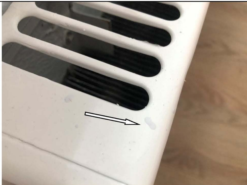
Фото №49. Загрязнения на кожухе отопительного прибора в спальне в квартире.
