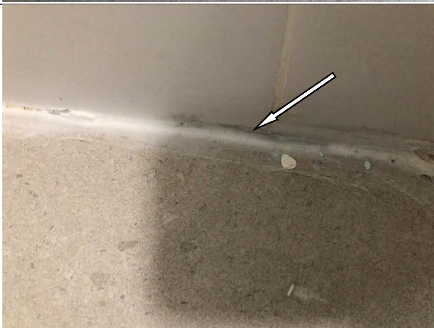
Фото №23. Загрязнения на напольной керамической плитке в ванной комнате в квартире.
