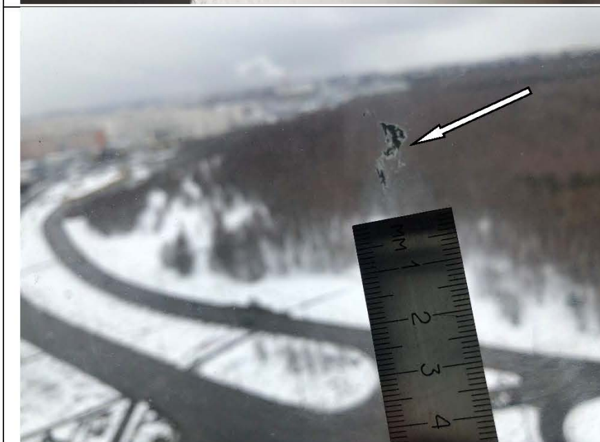
Фото №41. Загрязнения на стеклопакете оконного блока ПВХ в кухне в квартире.
