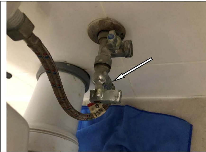
Фото №64. Следы протечки арматуры труб ХВС унитаза в ванной комнате в квартире.
