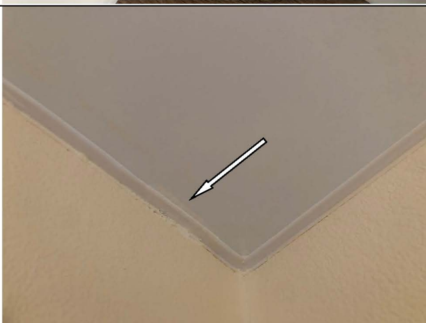
Фото №30. Загрязнения на полотне натяжного потолка в коридоре в квартире.
