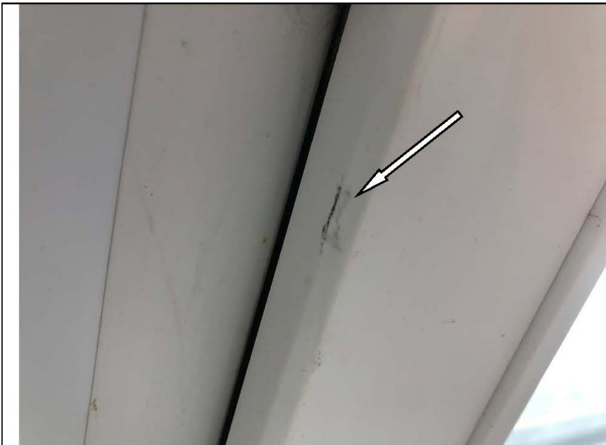
Фото №46. Загрязнения на профиле оконного блока ПВХ в кухне в квартире.
