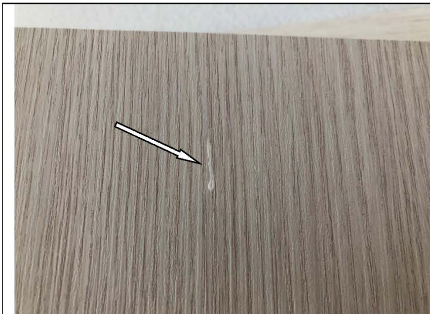
Фото №19. Загрязнения на полотне деревянного дверного блока в спальне в квартире.
