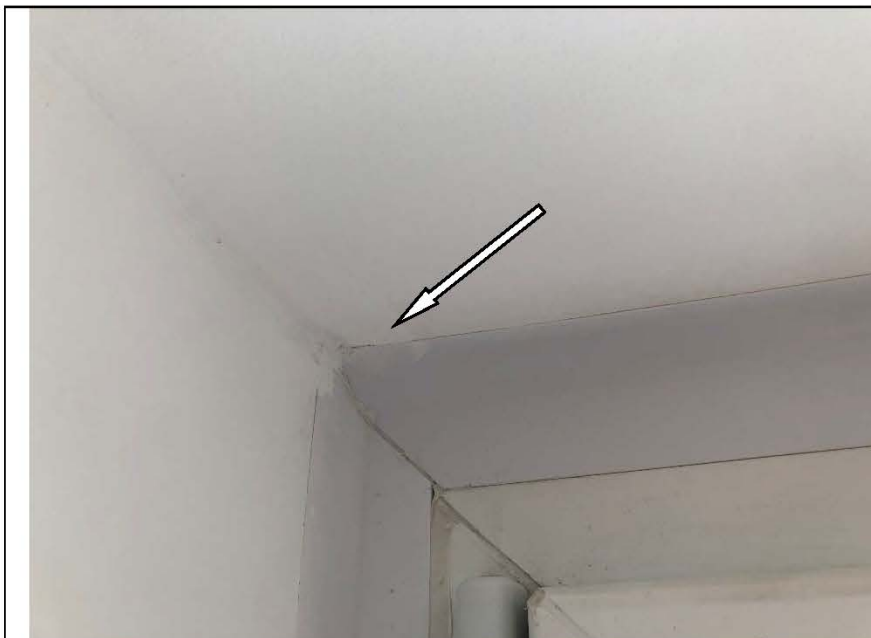
Фото №43. Инфильтрация оконного блока ПВХ в кухне в квартире.
