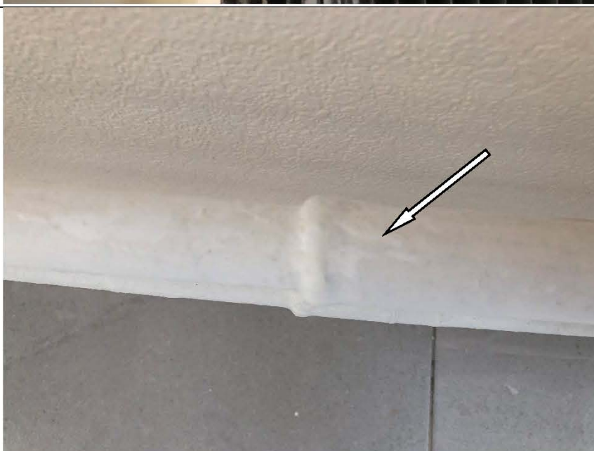
Фото №35. Неровности, сколы на окрашенных трубах отопления в кухне в квартире.
