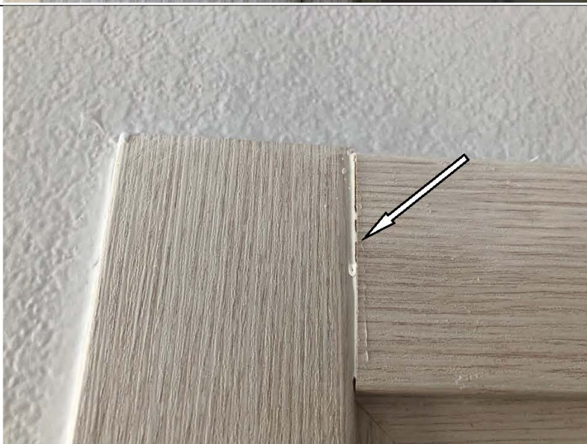
Фото №11. Загрязнения на наличнике деревянного дверного блока в спальне в квартире.
