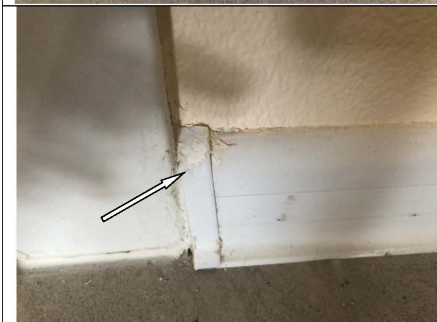
Фото №27. Загрязнения на напольном плинтусе ПВХ в коридоре в квартире.
