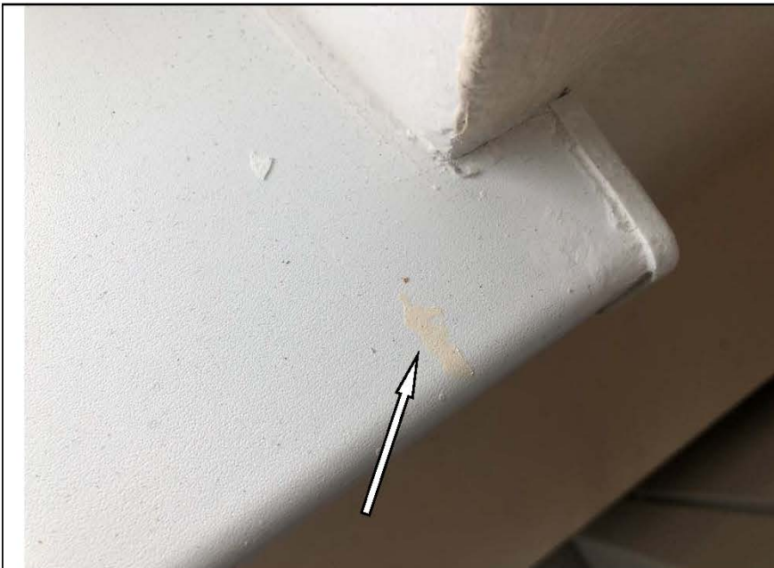
Фото №37. Загрязнения на подоконной доске в кухне в квартире.
