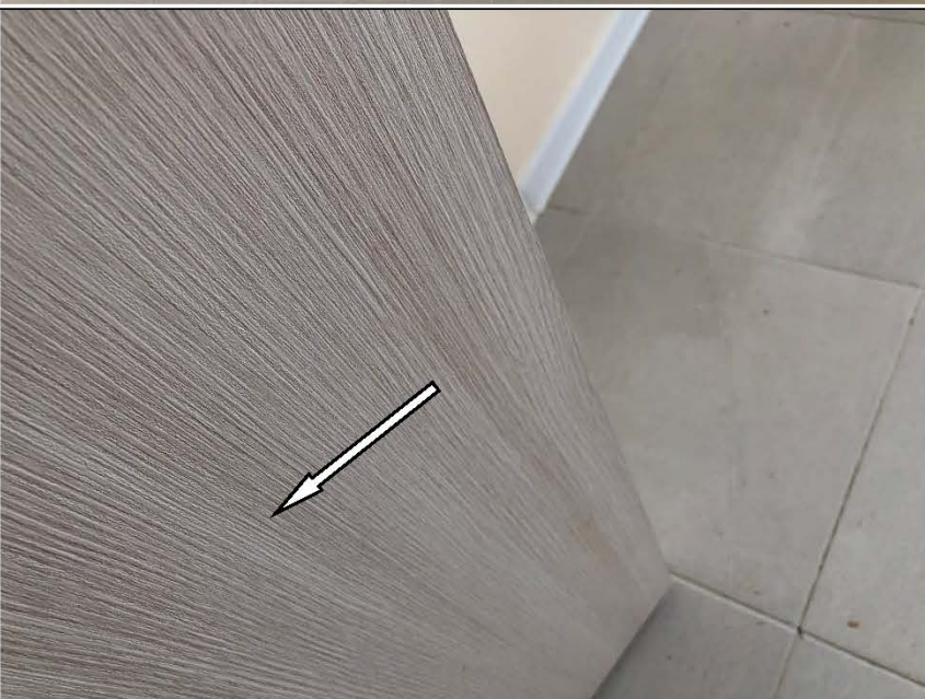
Фото №18. Загрязнения на полотне деревянного дверного блока в кухне в квартире.
