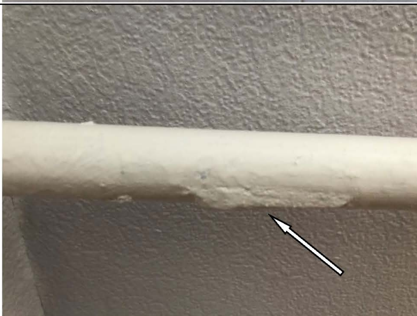
Фото №36. Неровности, сколы на окрашенных трубах отопления в спальне в квартире.
