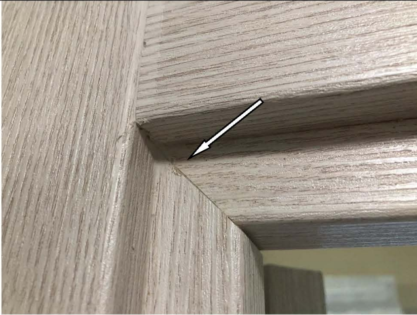
Фото №16. Загрязнения на коробке деревянного дверного блока в ванной комнате в квартире.
