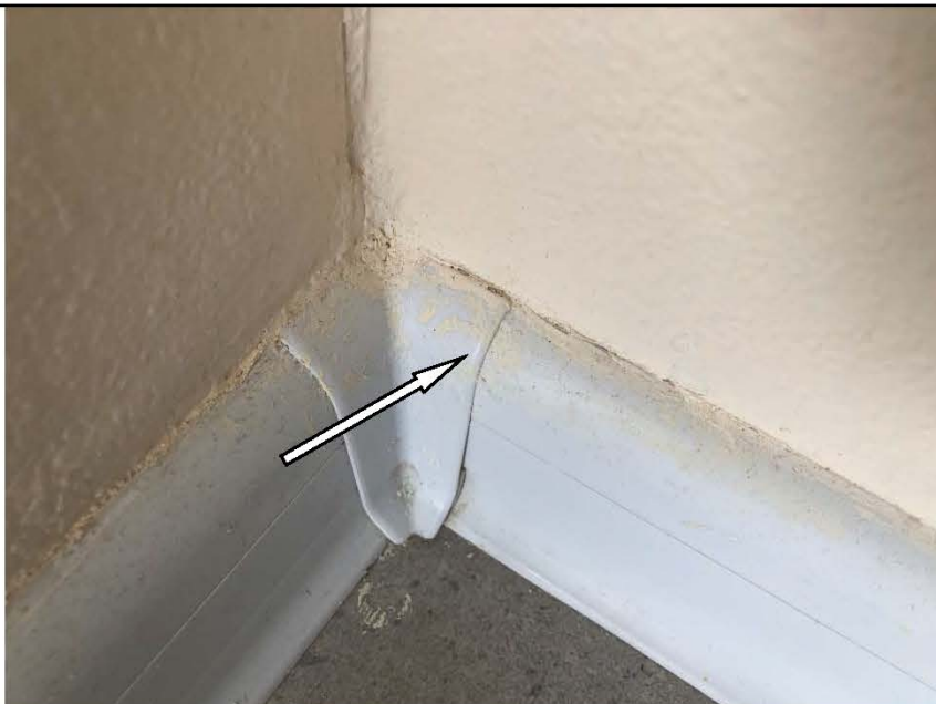
Фото №28. Загрязнения на напольном плинтусе ПВХ в кухне в квартире.
