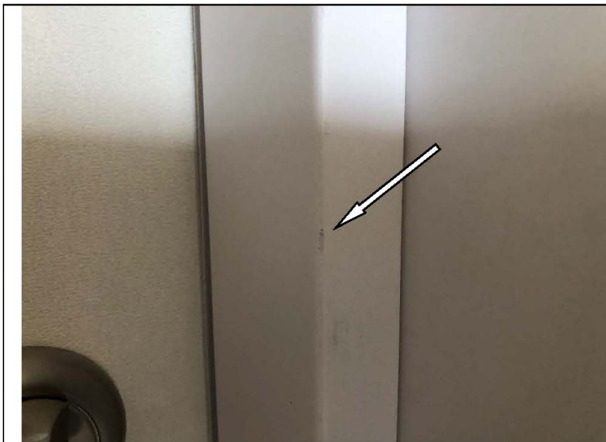
Фото №13. Скол на коробке комбинированного дверного блока в коридоре в квартире.
