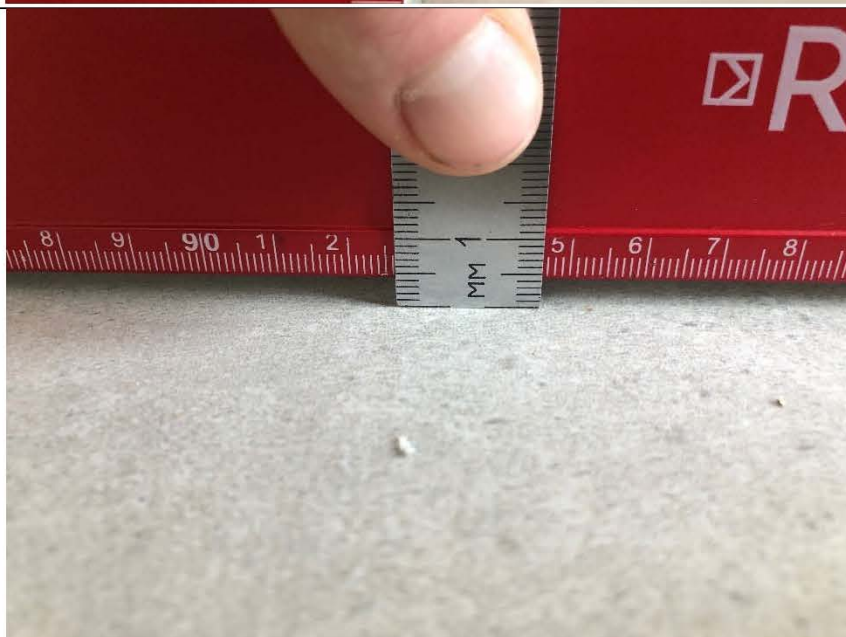
Фото №8. Измерение напольного покрытия в кухне в квартире.
