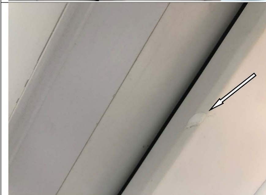
Фото №47. Загрязнения на профиле оконного блока ПВХ в спальне в квартире.
